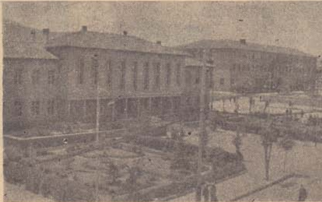
Malatya Belediye Binası
