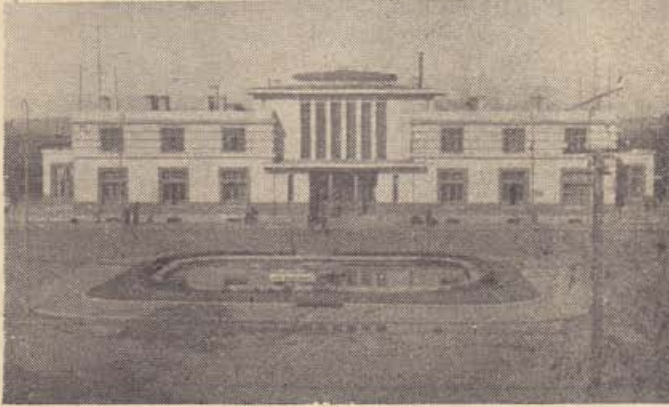
Malatya Gar binası
